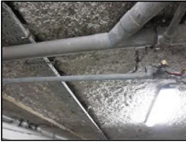
Photo N° 584 ECH-N°1 FLOCAGE -- PARKING Plafonds BLANC COTONNEUX
